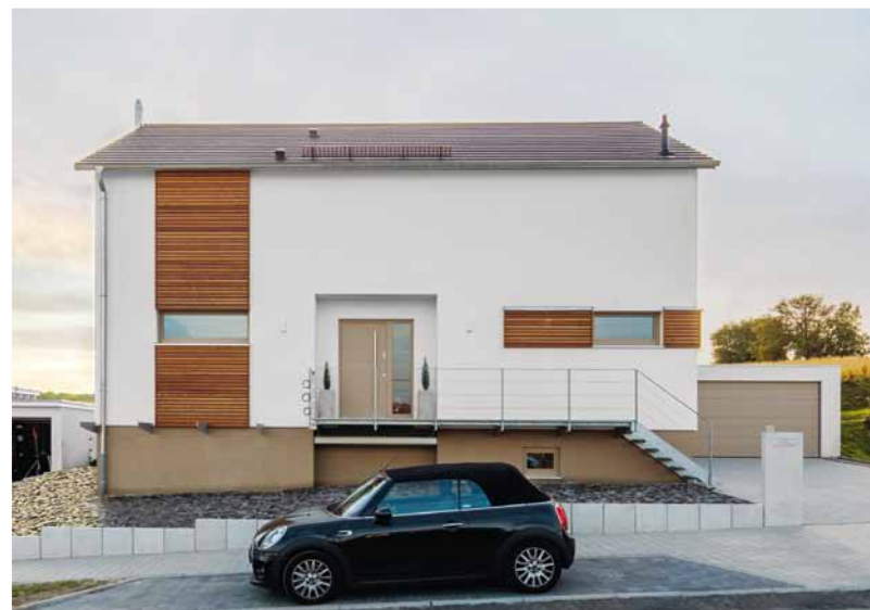
Nach Norden zur Straße hin zeigt sich das Haus zugeknöpft.
