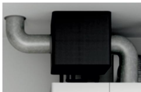
Mit dieser kleinen Box bewirken Sie erfrischende Wunder, denn falls Ihre Wärmepumpe mit einer Kühlfunktion ausgestattet ist, lässt sich dieser Nachluftherwärmer auch für das energieeffiziente **Nachkühlen der Zuluft** nutzen. Dabei kann nach Belieben temperiert und entfeuchtet werden.
